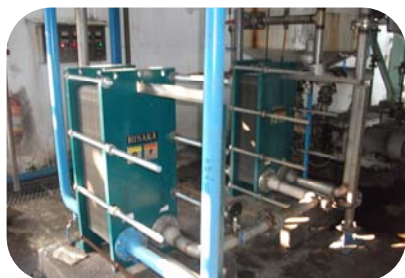
液化冷卻節能增設 板式熱交換器
