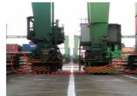
使用滑車組及滑軌轉換市電供給車
