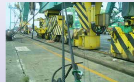
海側立柱加裝兩副鋼索，繫於纜樁固定
