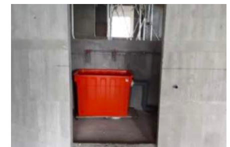
各樓層安裝沉澱池
