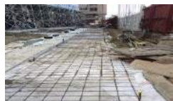
碎石上覆不織布，鋪蓋點焊鋼絲網。
