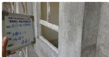
外牆打底施作
