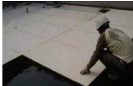
PS 隔熱板施作
