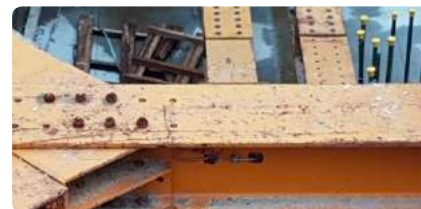
基地開挖安全支撐應變計定期觀測
