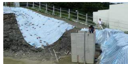
臨時沉砂池豎井
