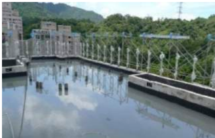
防水塗佈完成試水 48 小時
