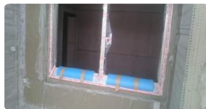
窗框二次防水
