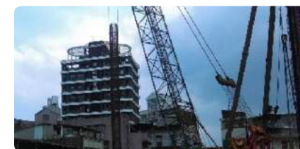
鋼筋籠吊放
