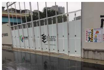
工區設有圍籬隔閡裡外
