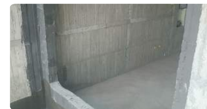
窗框防水施作
