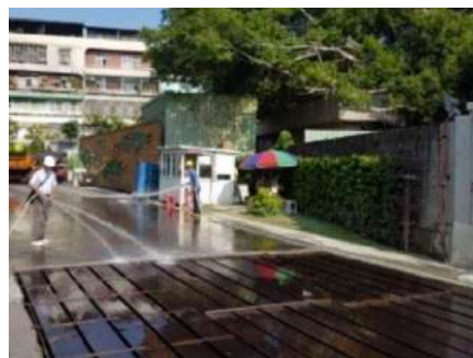
工地出入口保持清潔
