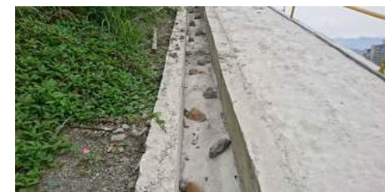
正式水保溝完成
