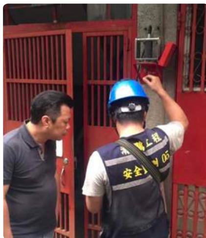
鄰房傾度盤架設
