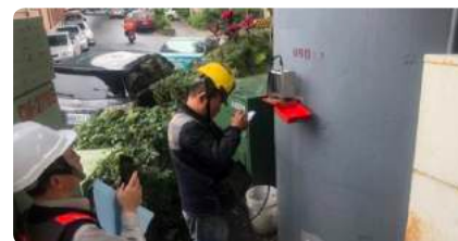
捷運橋墩傾度盤定期觀測
