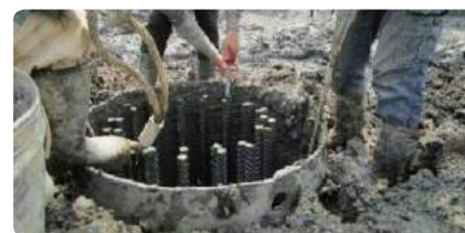
鋼筋籠高程確認
