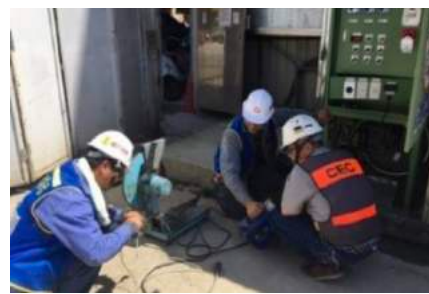
電動工具使用前漏電檢測
