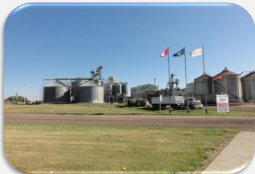
供應商倉儲設備
