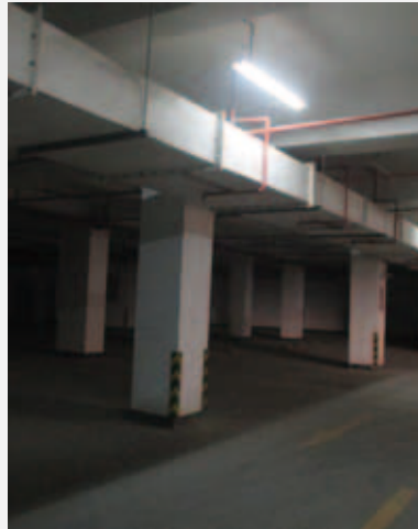
一期、二期全地下停車場
