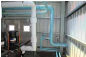
生產大樓空調改善
