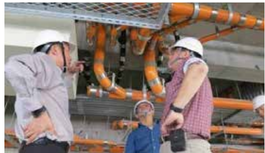
一樓平頂吊管施工後檢討後續維修通道之設置
