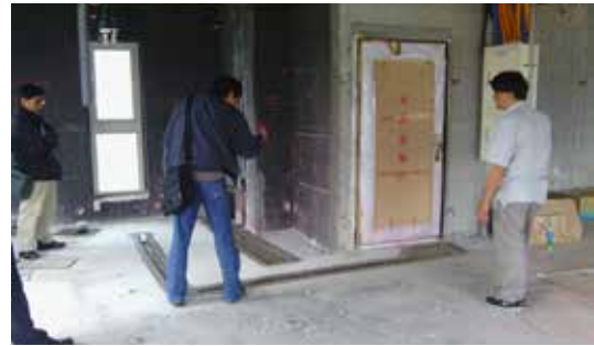
配合客簽、改管、防水施作後檢視
