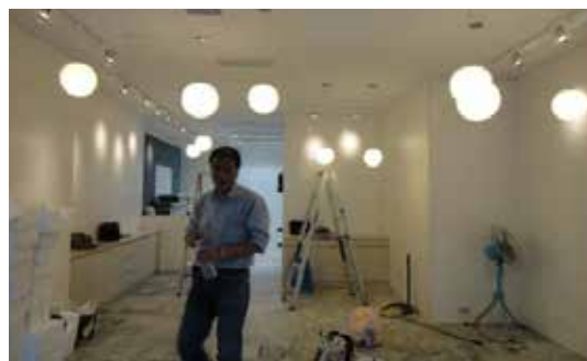
牆面封板、天花修補上漆、更換燈具及施作木作櫃體及遮屏
