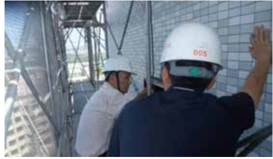
外牆拆架前檢視
