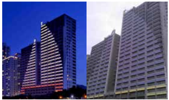
昇陽九樂外牆燈光時序控制 (ECO)
