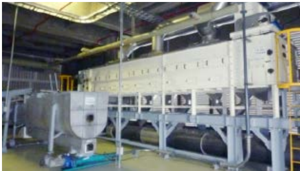
於有機污泥烘乾機及脫水機上方加裝排氣管
