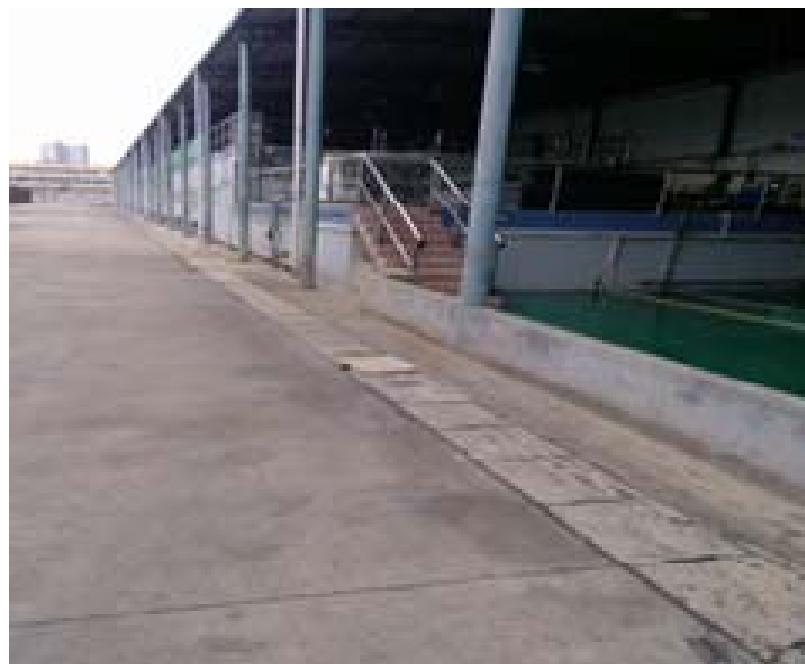
廢水處理改進工藝有效降低了危廢污泥的產生
