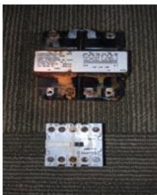
(汰換加壓風機啟動盤內的 變壓器及電磁接觸器)
